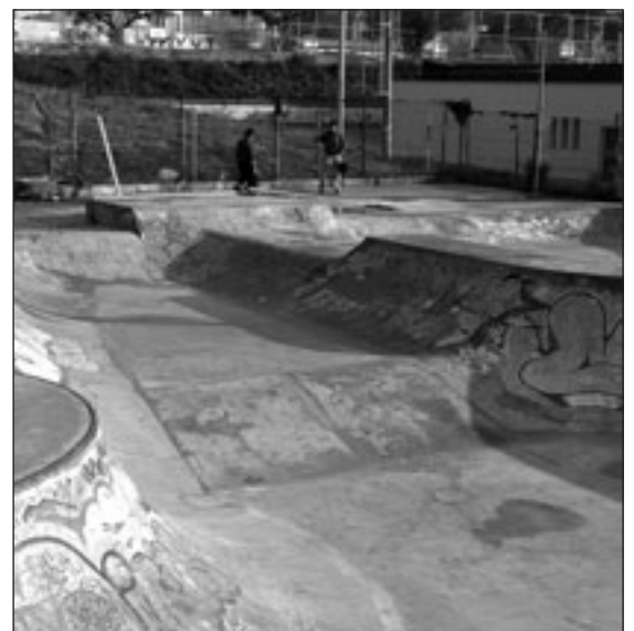
Obres d'arranjament a l'Skate Parc
