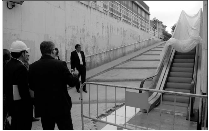
L'escala ja ha estat muntada al pas soterrat de Poble Sec
