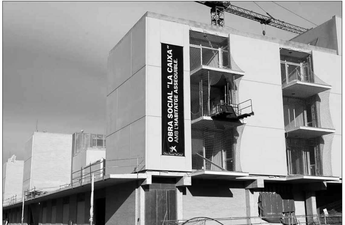
Obres de la promoció de pisos de la Blanca
